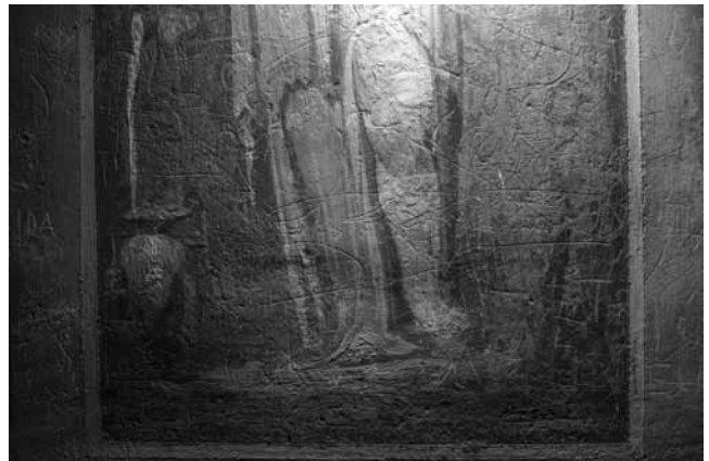
Fig. 12 – Villa d'Este, Sala della Gloria: visione ravvicinata, supportata dall'utilizzo di luce radente, della porzione inferiore del pannello 3.
