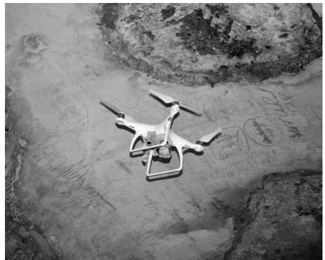
Fig. 2 - Villa Adriana, Criptoportico della Peschiera: rilievo fotografico con drone.
