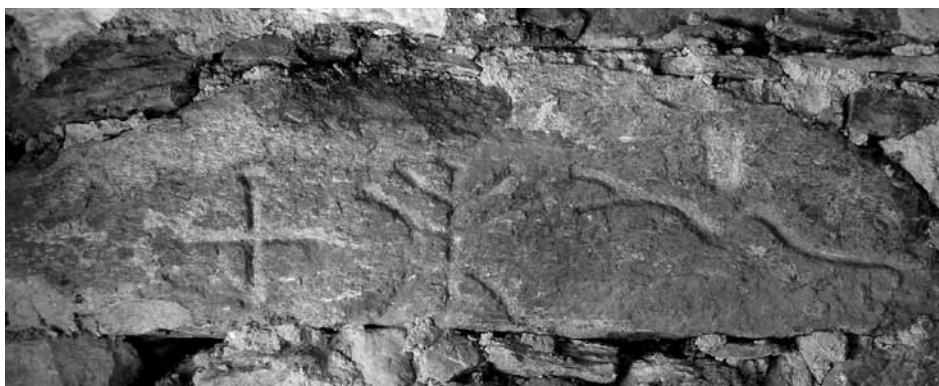
Fig. 11 - Architrave da Ponte (Cannero Riviera)
